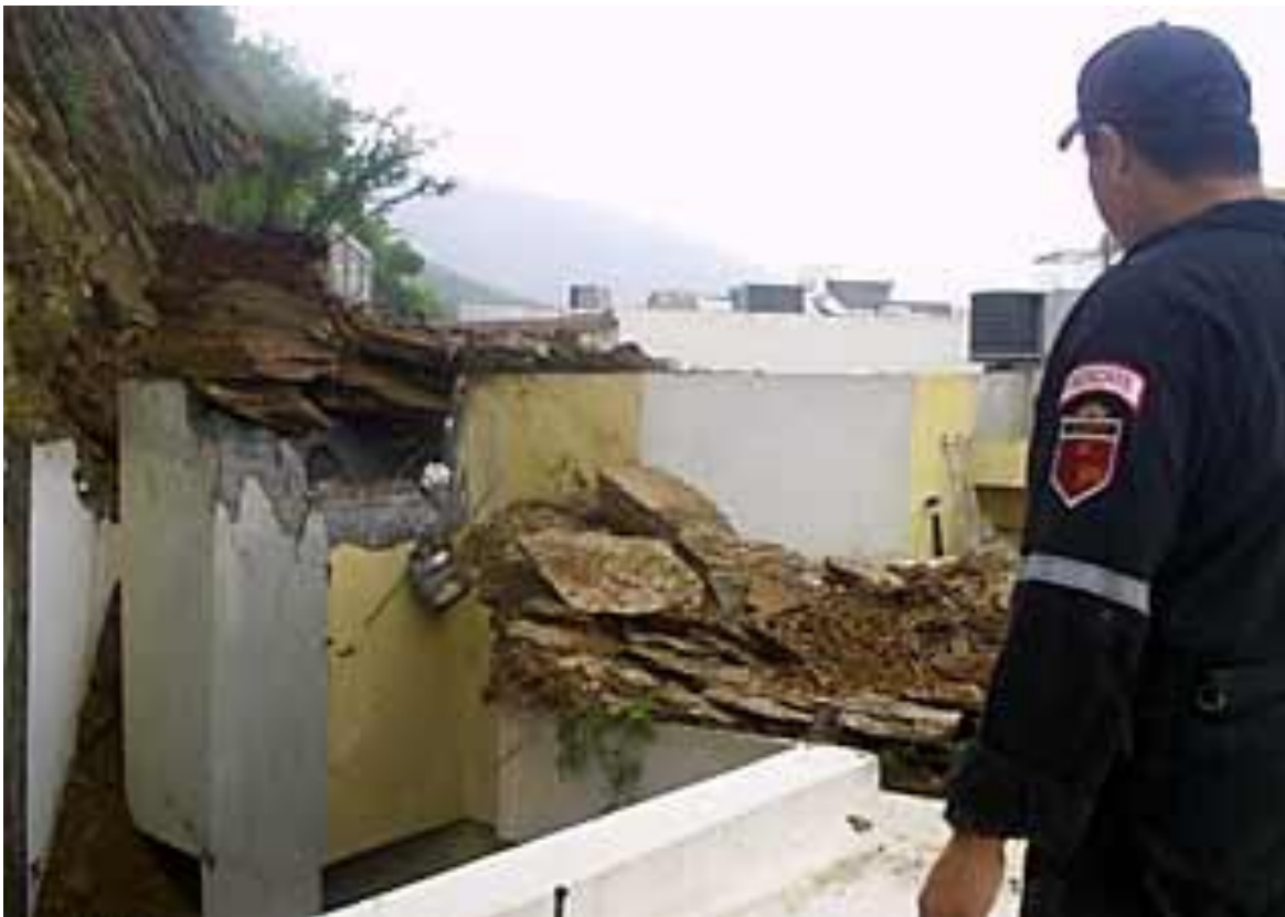
Fotografía II-9 Caído de rocas en una vivienda en San Agustín, sep. (El Norte, 2003)
