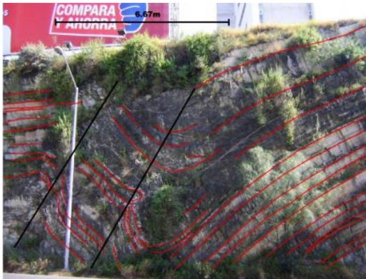
Fotografía VI-2 Zona de plegamiento identificada como 3.3.2. en (MSGG, 2012, pág. 15)
