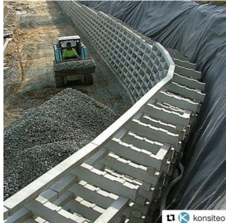
Fotografía V-9 Sistema Criblock en su fase de colocación (@GeotechTips, 2016)
