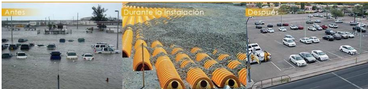
Fotografía V-1 Sistemas de gestión integral de agua: Retención, detención e infiltración (ADS Mexicana, 2017)
