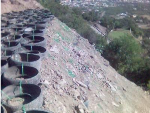
Fotografía V-7 Estabilización de relleno con llantas de desecho, (MHBB2016)
