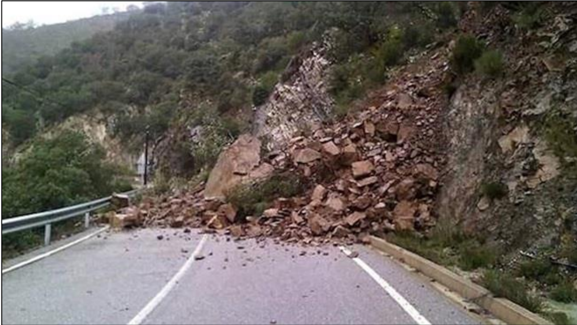
Fotografía II-5. Imagen de un deslizamiento de tierra. Fuente: (Yancy Aguilar, 2017)
