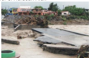
Destrucción del vado provocada por Huracán Alex.
