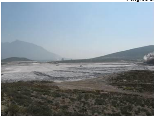
Fig.1.9 Confinamiento de sub-productos de las salmueras. El relleno químico de la empresa Álcali no afecta a población o zona habitacional alguna debido a que la superficie de la empresa es grande y estas se ubican a kilómetros, sin embargo
