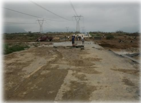
Depósito de material o tierra por araste del Cerro la Mota en la Av. Las Torres
